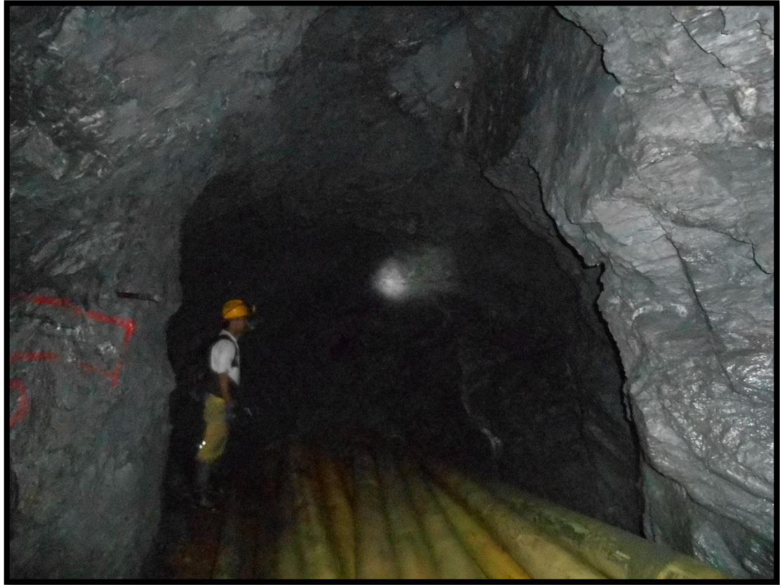
Figura 35. Nicho de instalación máquina perforadora; Guía Norte, Mina Gran Porvenir del Líbano.
