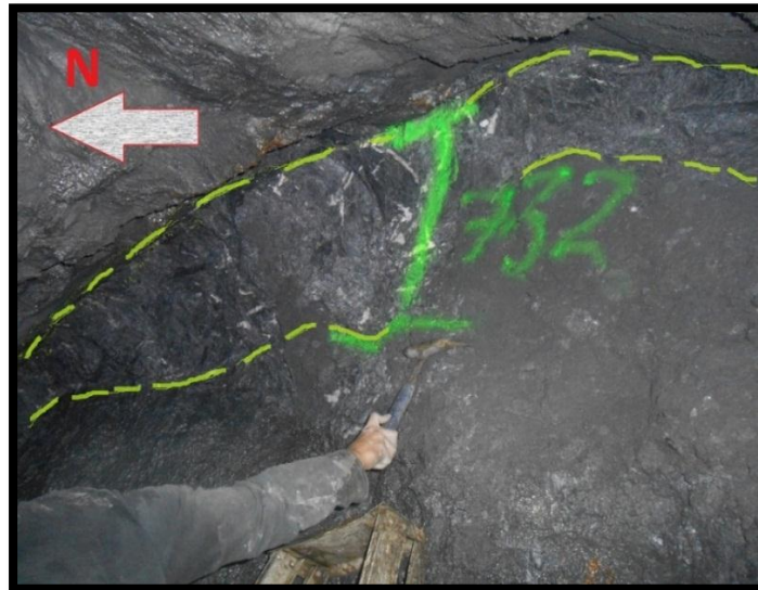
Figura 19. Salbanda generada por movimientos de bloques en zonas de cizalla con desplazamiento dextral correspondientes al sistema de fallas NW, Guía 3 interno norte; Mina El Gran Porvenir.
