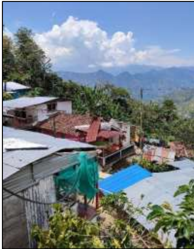
Figura 34. Fotografía tomada durante la visita 1 a viviendas afectadas en ladera descubierta. Fuente: propia.
