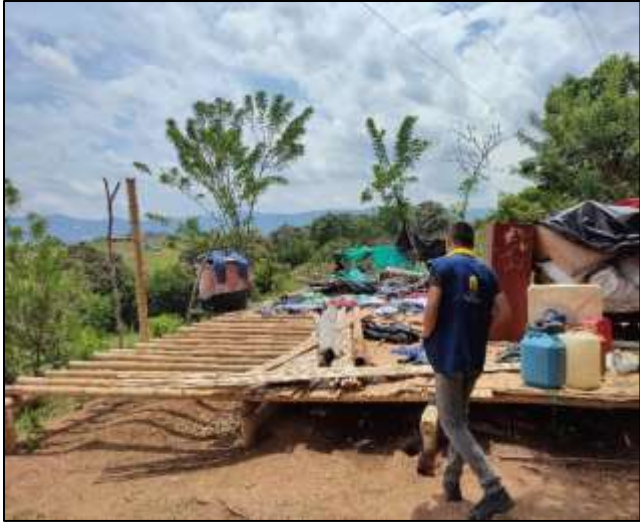
Figura 40. Fotografía tomada a la base de una de las viviendas afectadas construida en guadua. Fuente: propia.
