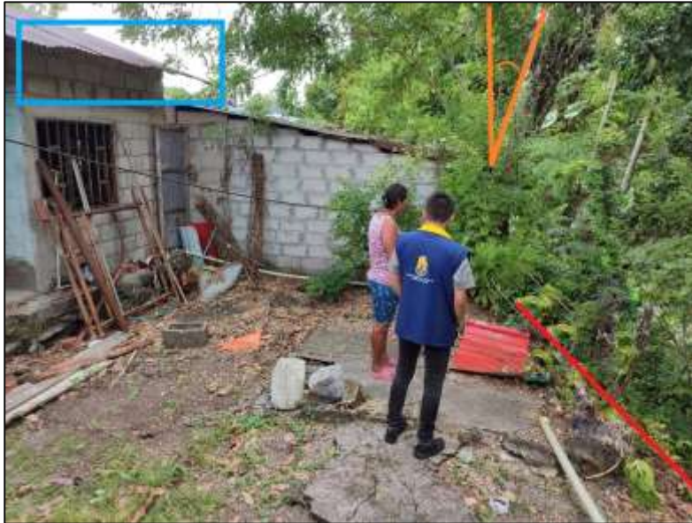
Figura 11. Patio del predio de la visita técnica 1; se evidencia el mal manejo de aguas lluvia (recuadro azul), vegetación inclinada y ladera de pendiente media. Fuente: propia.
