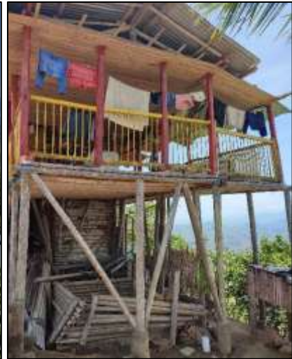
Figura 35. Fotografía tomada a una de las viviendas donde se evidencia el método constructivo común en la zona. Fuente: Propia.
