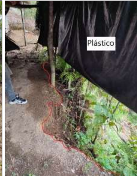
Figura 16. Patio del predio de la visita 3 donde se evidencia el plástico que vierte el agua de lluvia sobre la corona del deslizamiento. Fuente: propia.
