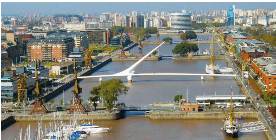
Figura 5. Puerto Medero, Argentina. Fuente: Freewalks.com
