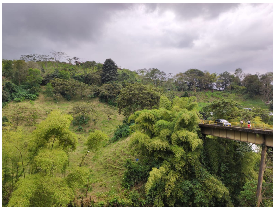
Figura 5. Depósitos coluviales margen izquierda del Río San Eugenio.
