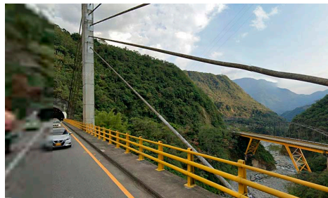
Figura 7. Nueva vía doble calzada Bogotá – Villavicencio. Fuente: Google 2018
