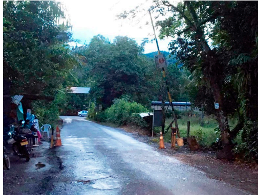
Figura 80. Cerramientos ilegítimos en condominios abiertos. Fuente: Elaboración propia
