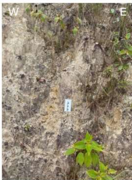
Figura 29. Afloramiento de la unidad geológica superficial: suelo residual a partir de la Formación Saldaña. Fuente: propia.
