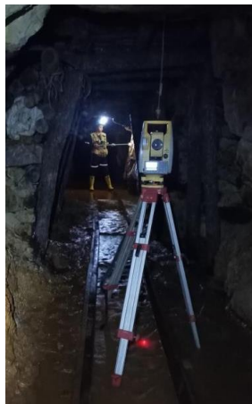
Figura 71. Personal del área de geología y topografía realizando el levantamiento topográfico del crucero 1838.
