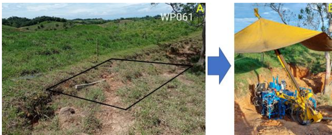
Figura 19. A. Punto de perforación ubicado con GPS en uno de los títulos mineros de la compañía. B. Maquina posteriormente instalada en el punto indicado en foto A.
