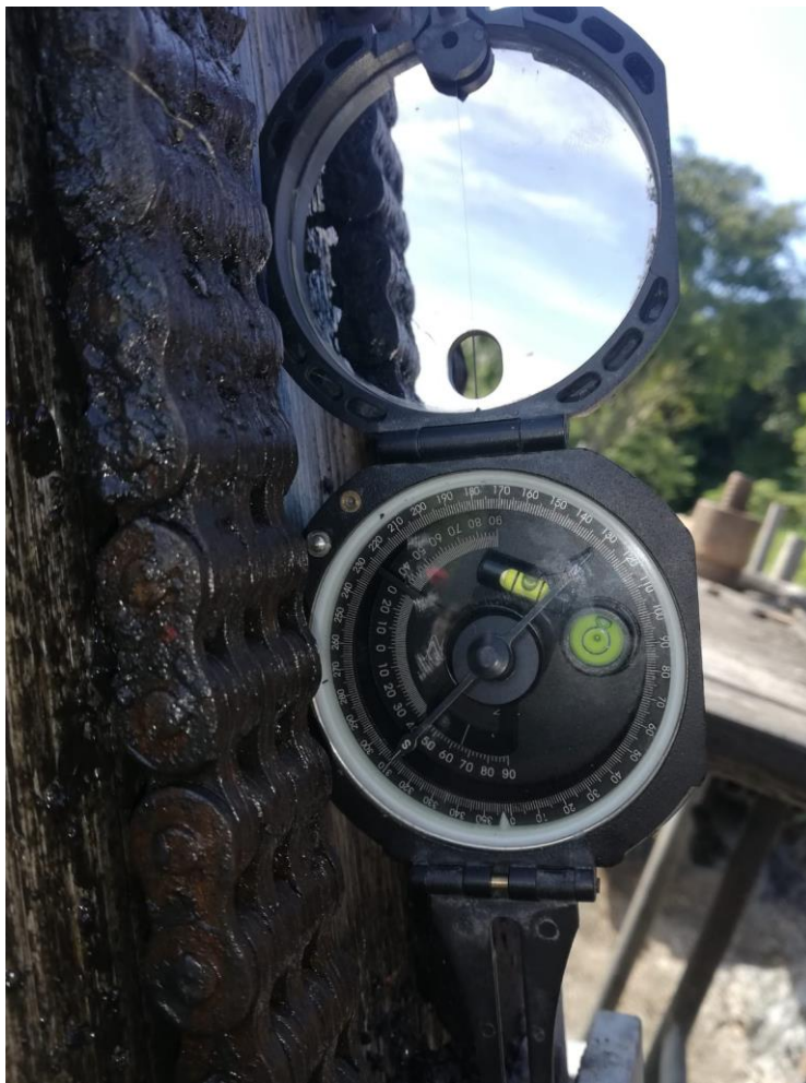
Figura 21. Proceso de orientación con brújula para equipo de perforación , en este caso se da inclinación a equipo.
