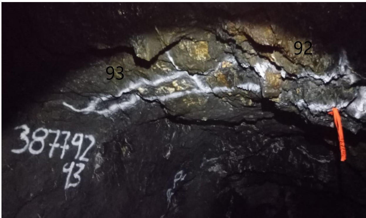
Figura 62. Canales pertenecientes al muestreo sistemático de la Sobreguía del Nivel 4, Mina La Agüita. Nótese los canales y la marcación de su punto de inicio(cinta naranja).
