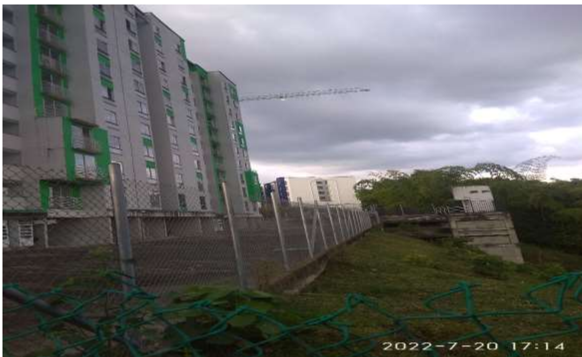
Figura 41. Construcción a borde de la microcuenca San José
