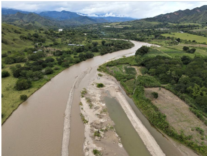
Registro fotográfico 27. Imagen obra de mitigación sobre el Río Suaza, municipio de Suaza. Imagen tomada por el fuente propia.
