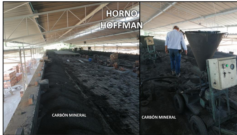
Registro fotográfico 40. Horno Hoffman (parte superior). Fuente propia.
