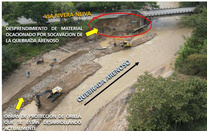
Registro fotográfico 2. Imagen zona afectada, puente arenoso. Tomada y editada por fuente propia.
