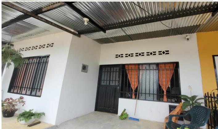
Registro fotográfico 26. Imágenes predio ubicado en la calle 12 No. 6-12. Imágenes tomadas por el autor y editadas por fuente propia.
