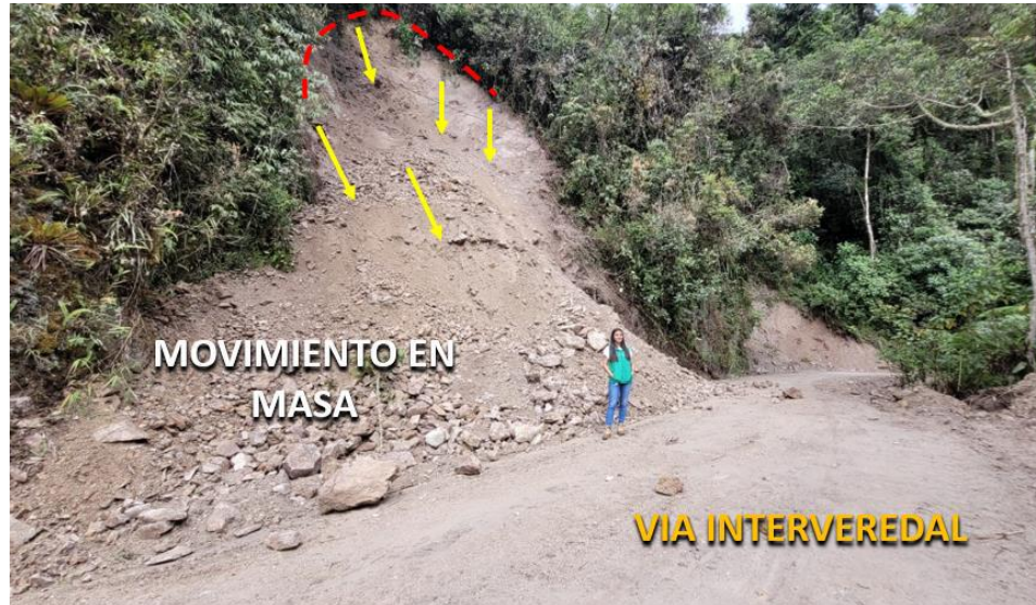
Registro fotográfico 24. Imagen movimiento en masa (deslizamiento rotacional) ubicado en el predio objeto de restitución. Imagen tomada y editada por fuente propia.
