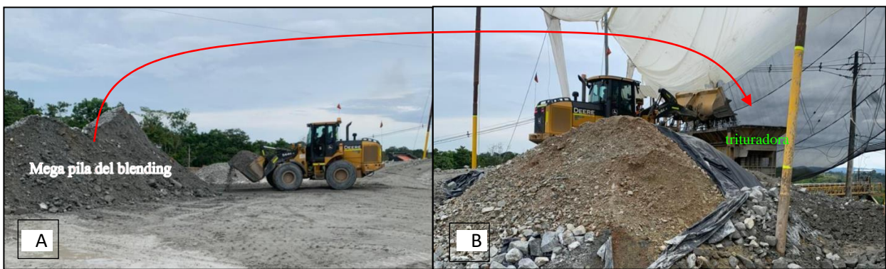
Imagen 43. (A) se observa la remoción del material generado por el blending (Imagen 36), para ser llevado por la cargadora hacia la trituradora principal (B), el cual deja las partículas en tamaño gravilla; Fuente: propia.
