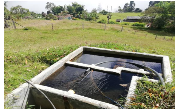
Imagen 2 Tanque de Almacenamiento Fuente: Toma propia
