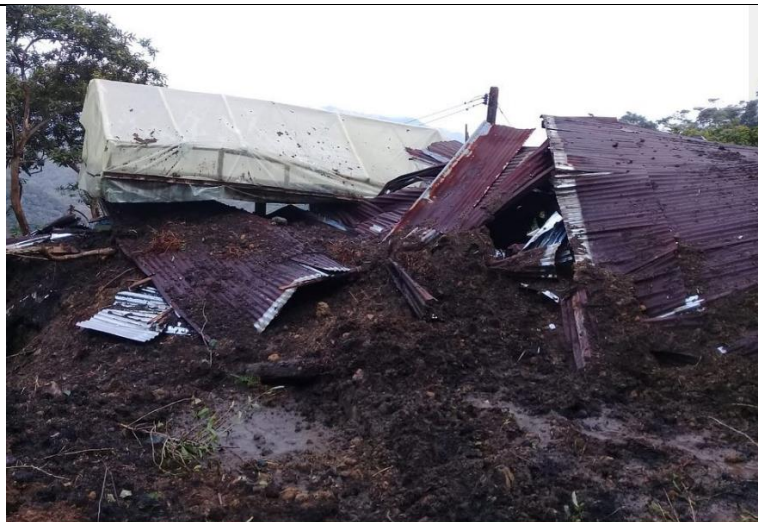
Imagen 11 Emergencia por deslizamiento Fuente: Jefatura de Gestión del Riesgo de Desastres
