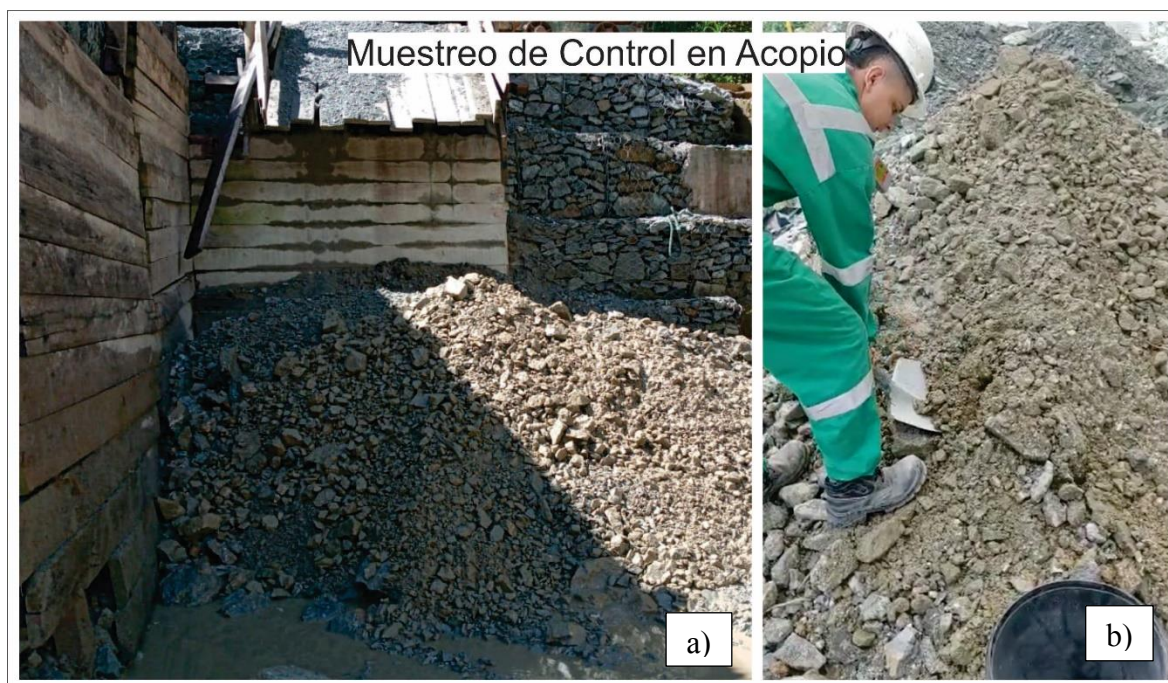
Figura 30. Muestreo de Control en Acopios. a) el material es apilado directamente por el descargue de las vagonetas en los acopios. b) La muestra de control de acopio se toma con pala, recolectando un poco a lo largo y ancho de toda la pila.
