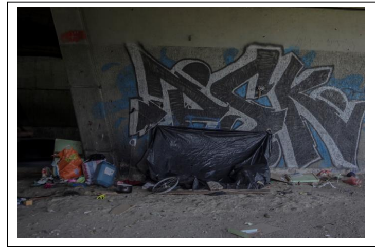
Imagen 55. ● Puente Av. San Juan (Medellín-Colombia) Fuente: Juan F. Pérez (2019) (Salida No. 5, domingo 28 de julio de 2019, 10:15 a.m.)
