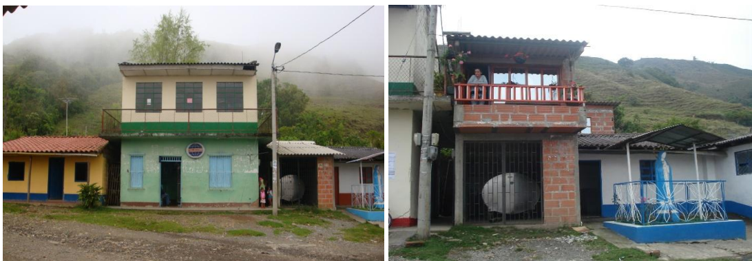
Fotografía 22. Ubicación del tanque de leche (Izquierdo). Una vivienda encima del tanque de leche (Derecho).
