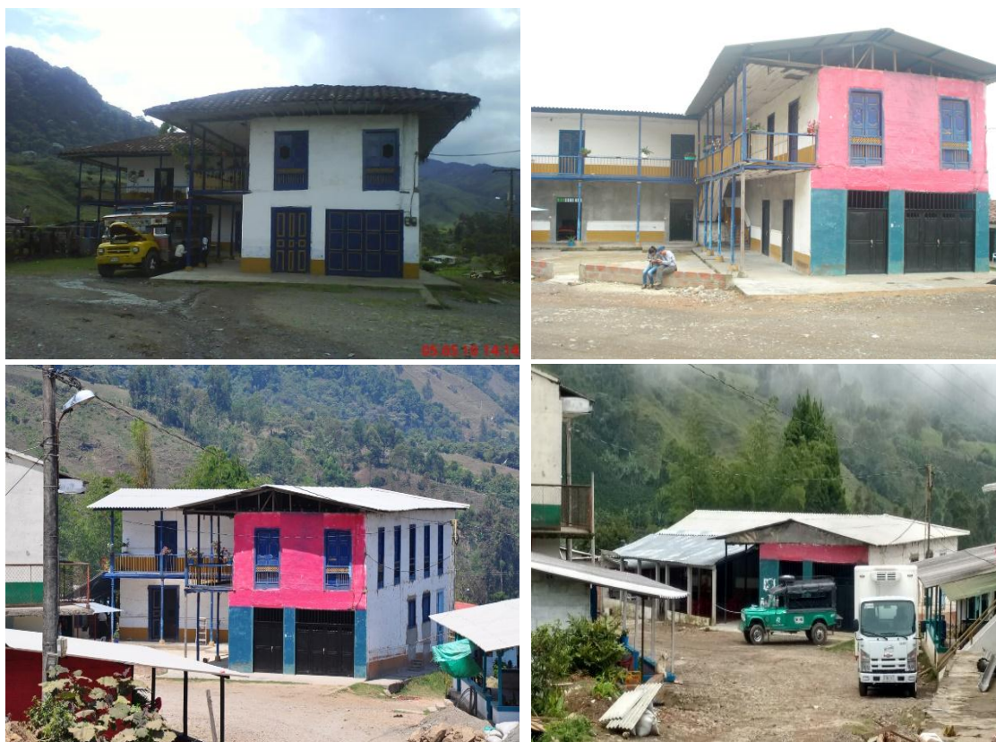
Fotografía 28. Arriba a la izquierda, la Fonda construcción inicial. Arriba a la derecha y abajo, las transformaciones que se fueron dando por el nuevo propietario, generando conflicto con sus vecinos y una transformación drástica del paisaje.
