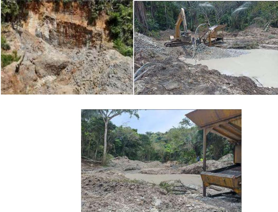
FIGURA 6. Procesos de adecuación, arranque y beneficio en explotaciones de oro aluvial en fosas
