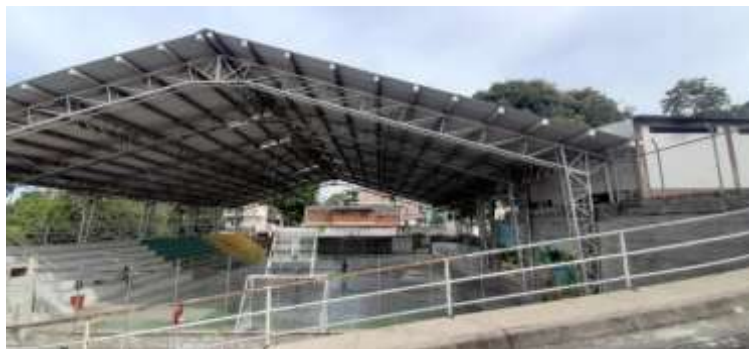
Figura 31. Cancha del Colegio San Gerardo María Mayela. Fuente: Foto tomada por el autor, 2022.
