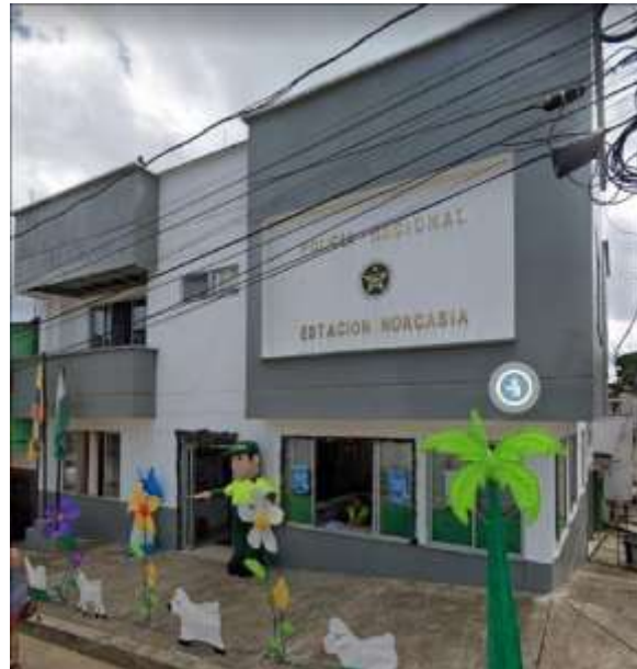
Figura 34. Estación de policía remodelada en 2021. Fuente: Google Maps, 2022.
