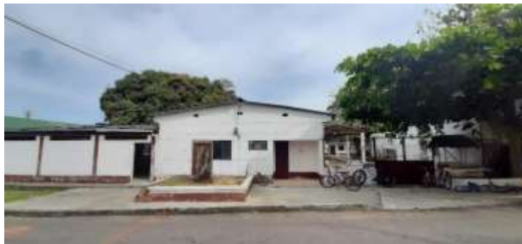
Figura 30. Colegio San Gerardo María Mayela en construcción de nuevos espacios. Fuente: Foto tomada por el autor, 2022
