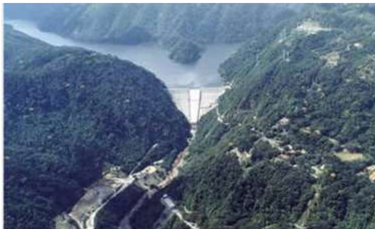
Figura 2. Construcción vía la DORADA- NORCASIA proyecto miel 1 contrato A005/94 mayo 1994 – febrero 1996. Tomado de: (INARCON, 1994)
