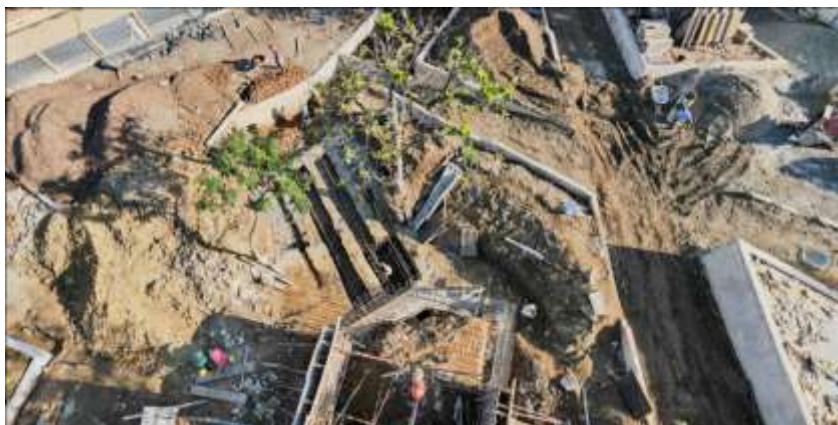
Figura 26: Parque principal en Febrero del año 2022, remodelación del parque. Fuente: Jhon Jario Mejia, 2022.
