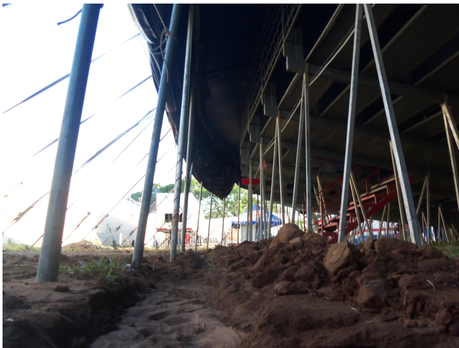
Fotografía 8. Zanja de desagüe. 11/08/15. Montería, Córdoba. Fuente: Propia.
