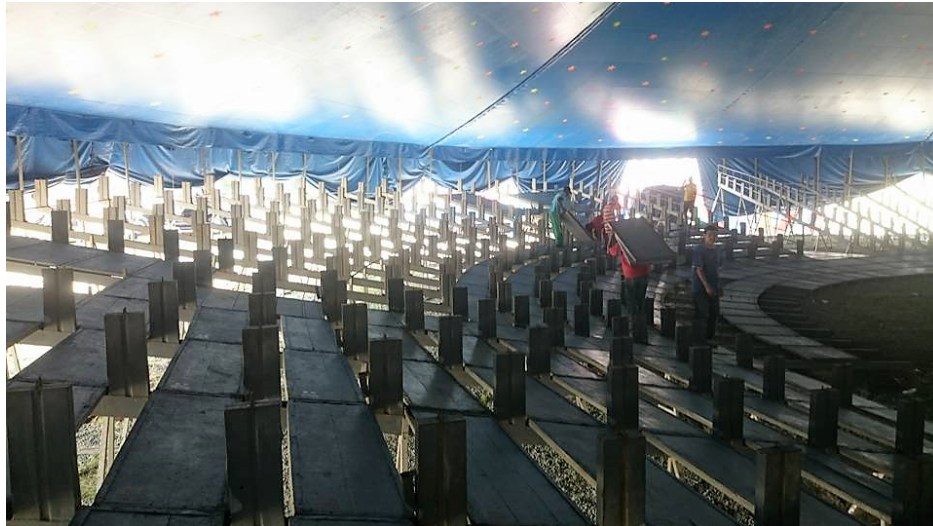
Fotografía 11. Tendido escalonado. 02/09/15. Barranquilla, Atlántico. Fuente: Propia.
