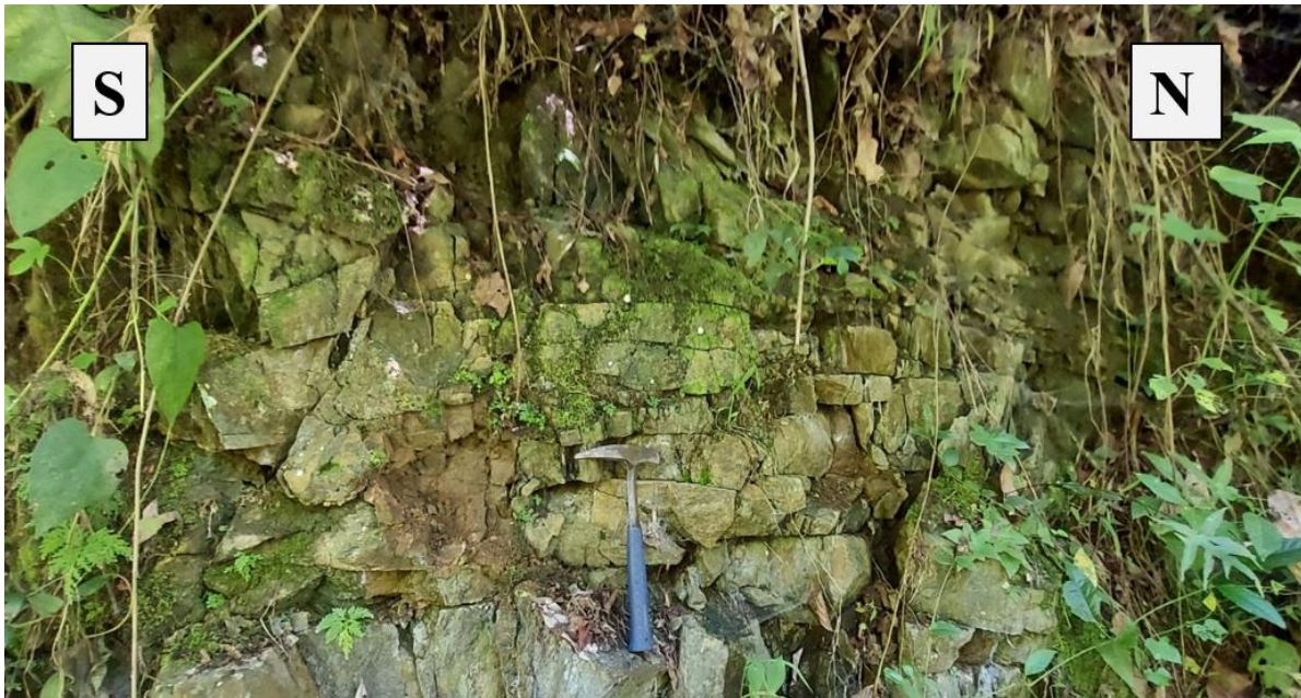
Figura 11. Afloramiento de toba de cristales diaclasados, en horizonte de meteorización IIB y resistencia R3, sector obras de derivación.
