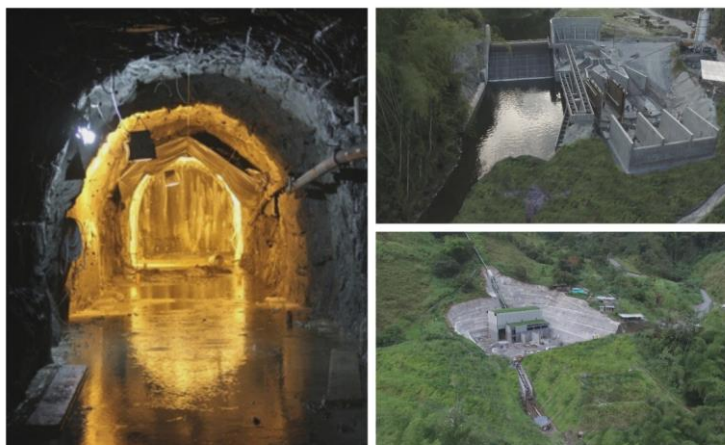
CENTRAL HIDROELECTRICA EL EDÉN Fuente: http://www.latinco.co/eden
