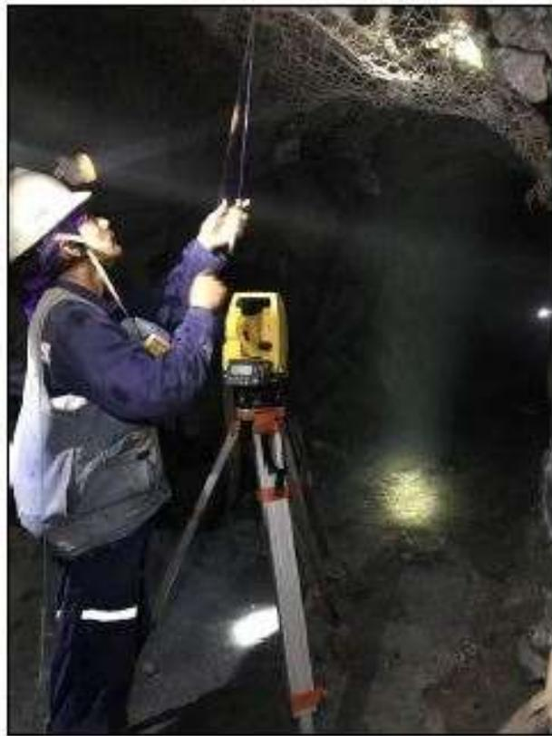
*Figura 11. Levantamiento de trabajos subterráneos usando estación total; SRK Consulting Inc. (2020).*
