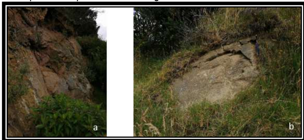
Escarpe de alta pendiente a lo largo de una línea de falla
