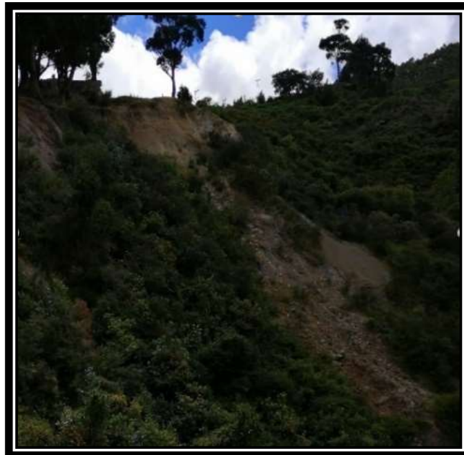
Fotografía 8 Depósitos de ladera.
