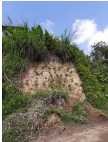
Figura 39. Deslizamiento traslacional.
