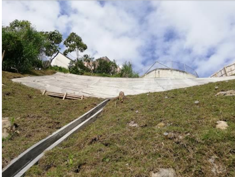
Figura 22. Pantalla con anclajes pasivos talud superior. Apuntillamiento talud inferior
