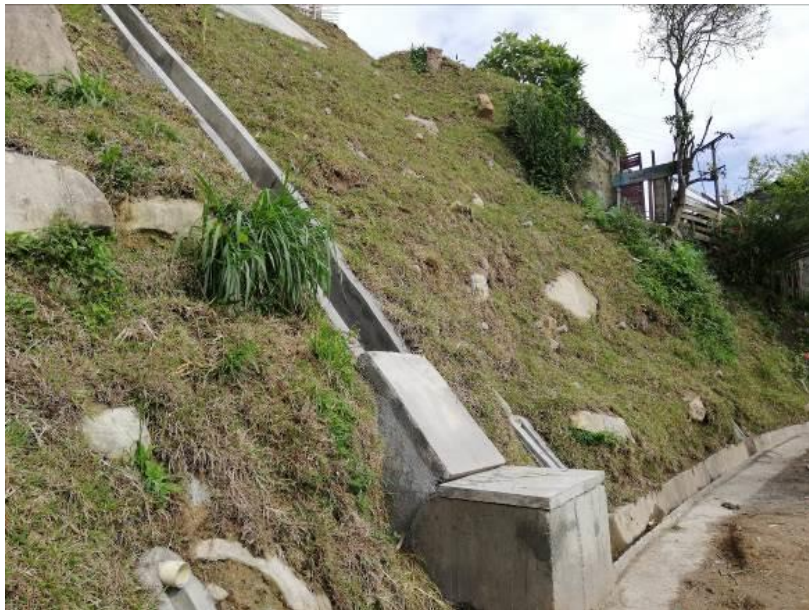
Figura 23. Empradización Talud Inferior.
