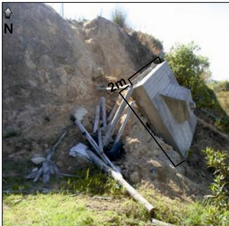
Figura 3. Perno. Se encuentra removido del terreno y en su parte de atrás resquebrajado.
