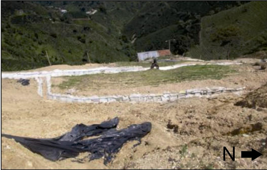
Figura 5. Canales recolectores de agua. En la zona inferior de la foto geotextil y en la superior canales en saco suelo, el agua se desvía de ellos formando surcos en el terreno.
