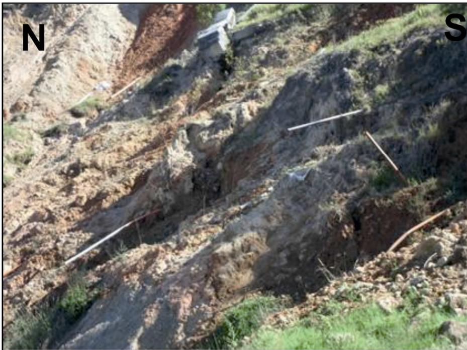
Figura 4. Drenes. Sobre la parte superior de la cárcava estas estructuras se observan aleatoriamente sobresaliendo del terreno y con escasa salida de agua.
