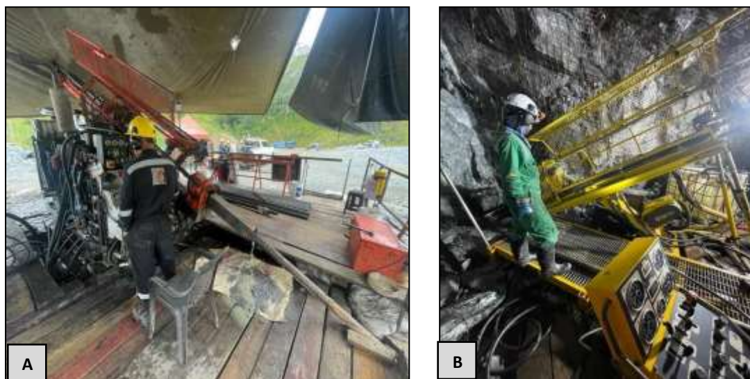
Figura 41. A) Máquina de perforación ubicada en superficie. B) Máquina de perforación ubicada en interior mina. (Fuente: autor)
