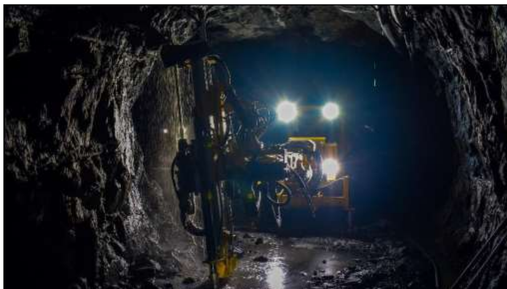
Figura 51. Jumbo para taladros largos operando en interior mina. (Fuente: Yessid Acevedo)
