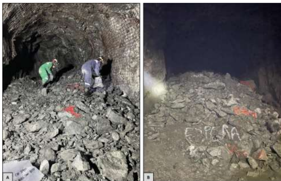
Figura 58. Pila de material rocoso proveniente de un avance horizontal. A) Auxiliares de geología realizando muestreo de carga debido a dificultad para decidir qué tipo de material corresponde. B) Ejemplo de carga con marcación en espera. (Fuente: autor)
