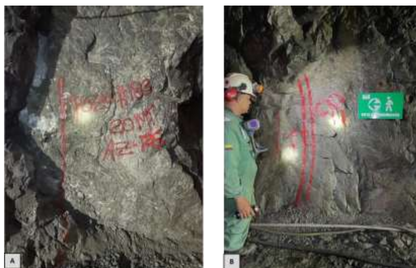
Figura 60. Marcación con brújula y aerosol de pozo a perforar en mina Guayabito. A) marcación de rumbo del pozo. B) marcación del contra rumbo. (Fuente: autor).
