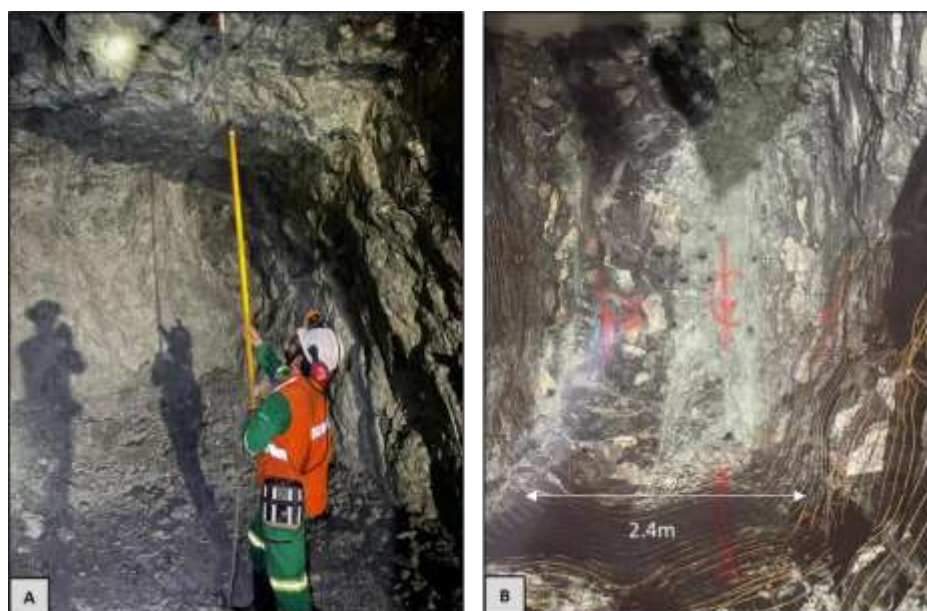
Figura 57. A) Marcación en campo de eje galería, B) Se observa en galería de la mina Guayabito con marcación de centro, eje y límites externos. (Fuente: autor)
