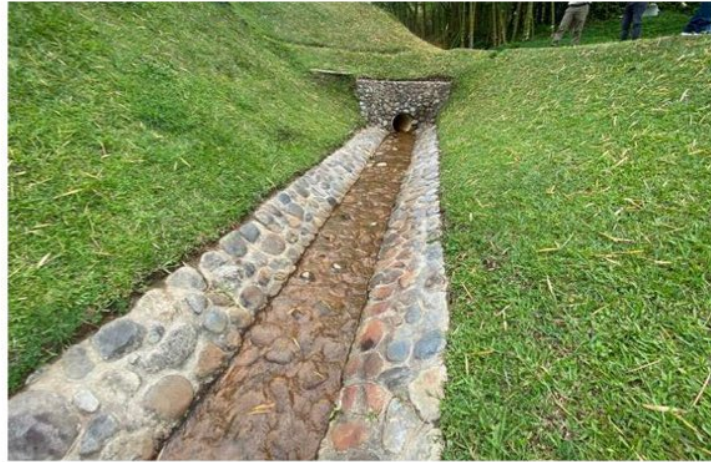
Imagen 4. Obras de encauzamiento o canalización del río para aumentar su capacidad hidráulica.
