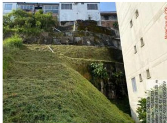
Imagen 14. Obras de estabilidad, buen manejo del agua de escorrentía. Medidas preventivas y de mitigación del riesgo en el sitio revisado. Fuente: propia.
