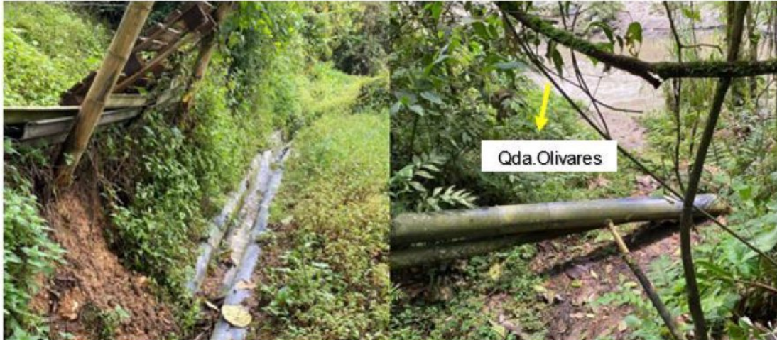
Imagen 17. Obras para el manejo de aguas de escorrentía y su respectivo descole a la Q. Olivares.
