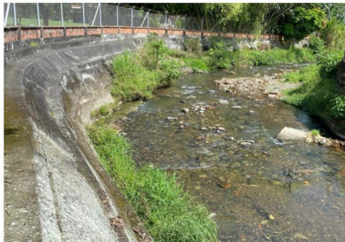
Imagen 3. Muro de contención de concreto. Fuente: Propia.
