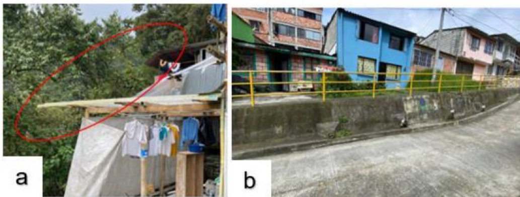
Imagen 16. a) Mal manejo de aguas lluvias cubierta, caen al talud. b) Obras de estabilización CORPOCALDAS. Fuente: propia.
