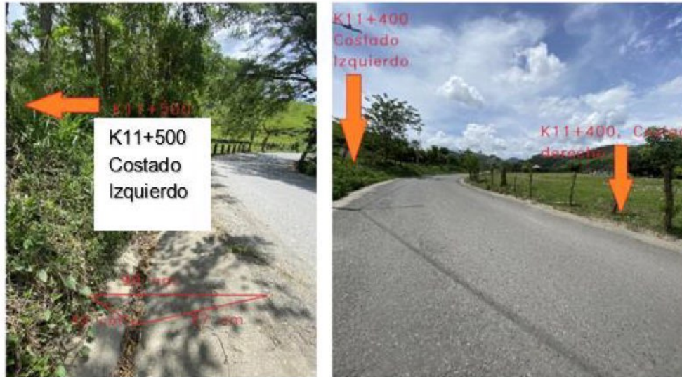
Imagen 11. En ambas imágenes se puede evidenciar la construcción de las cunetas viales, y la estabilidad y revegetalización de las zonas de depósito utilizadas. Fuente: Propia.
