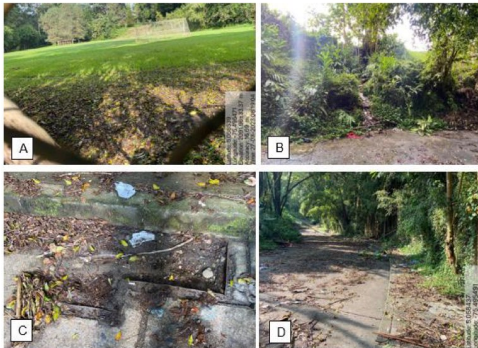
Imagen 22, Collage estado actual de los puntos analizados, A. Uso del lleno, escenarios deportivos, cuenta con filtros y cunetas perimetrales que descolan correctamente al cauce natural. B. Factores antrópicos que aumentan la amenaza: Depósito de basura en el talud. C. actores antrópicos que aumentan la amenaza: sumideros completamente colmatados. D. Infraestructura urbana en la zona. Fuente: propia.
