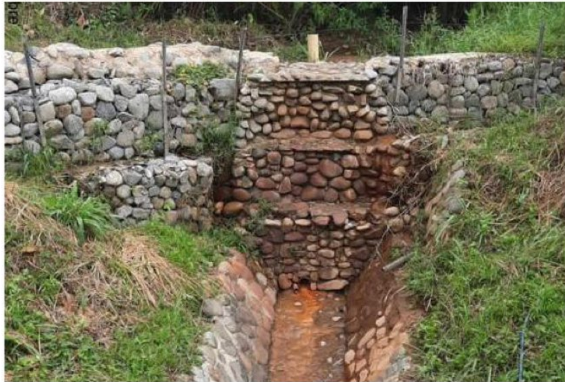
Imagen 2. Muro de contención en gavionería. Fuente: Propia.
