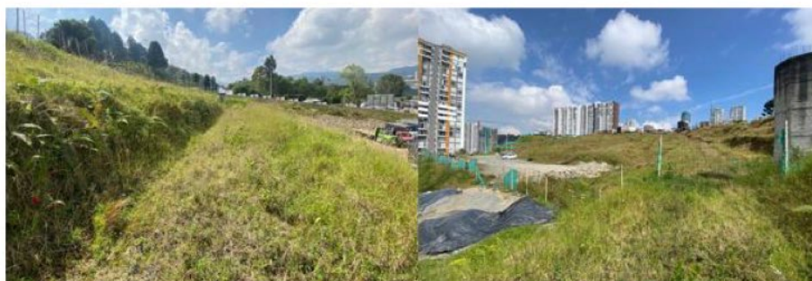
Imagen 19. Sector sin infraestructura y en buenas condiciones generales de estabilidad y manejo de agua de escorrentía.
