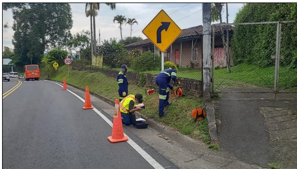
Figura 12. Ejecución de SEV en campo.
