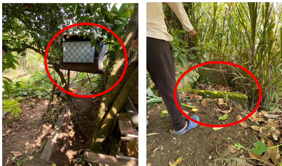
Imagen 12. Cargas en la parte superior del talud.
