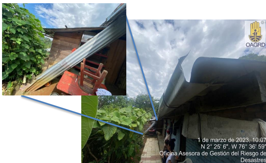
Imagen 10. Canalización de aguas lluvias en la parte frontal de la vivienda.
