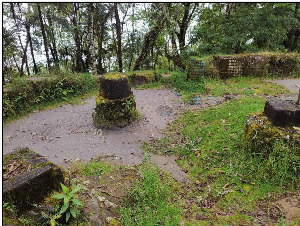
*Imagen 26. Fotografía de los cimientos de Hormigón de las torres del Cable Aéreo.
