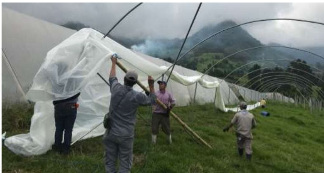
Figura 24: Ubicación del plástico sobre las carevacas. (Orozco Orjuela 2017)
