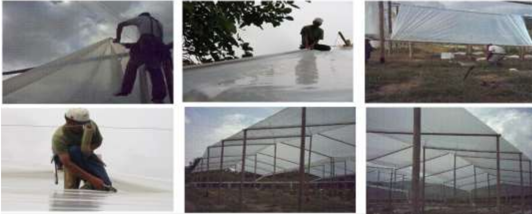
Figura 14. Culminación de la instalación. (Parra et al., 2020)
