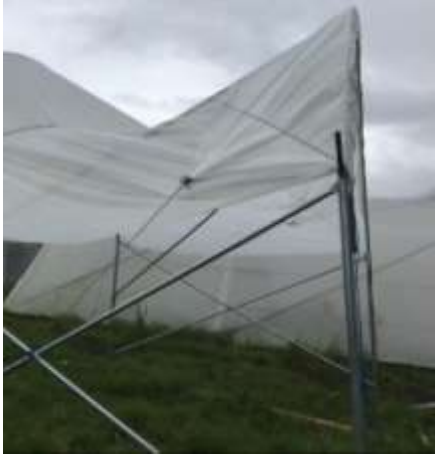
Figura 25: soga pisadora fija a la estructura. (Orozco Orjuela 2017)
