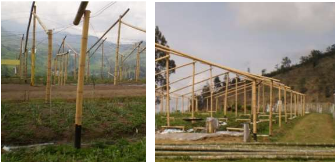
Figura 11: Columnas impermeabilizadas y alineadas, (Duque, 2013)
