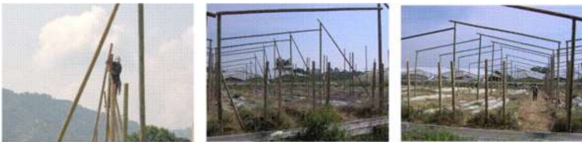
Figura 12 Instalación de alfardas. (Parra et al., 2020)
