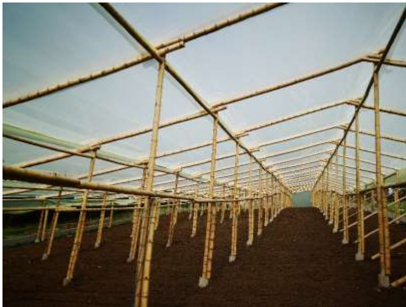
Figura 15: Estructura de invernadero finalizada. (Orozco Orjuela, 2021)
