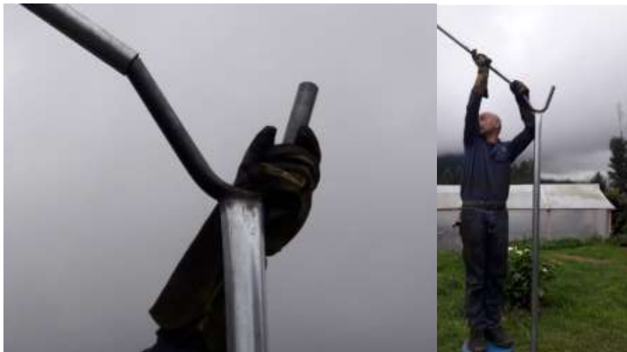
Figura 23: Instalación de arcos. (Orozco Orjuela 2017)
