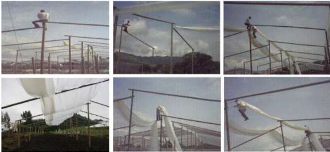
Figura 13: instalación de la cubierta plástica, (Parra et al., 2020)
