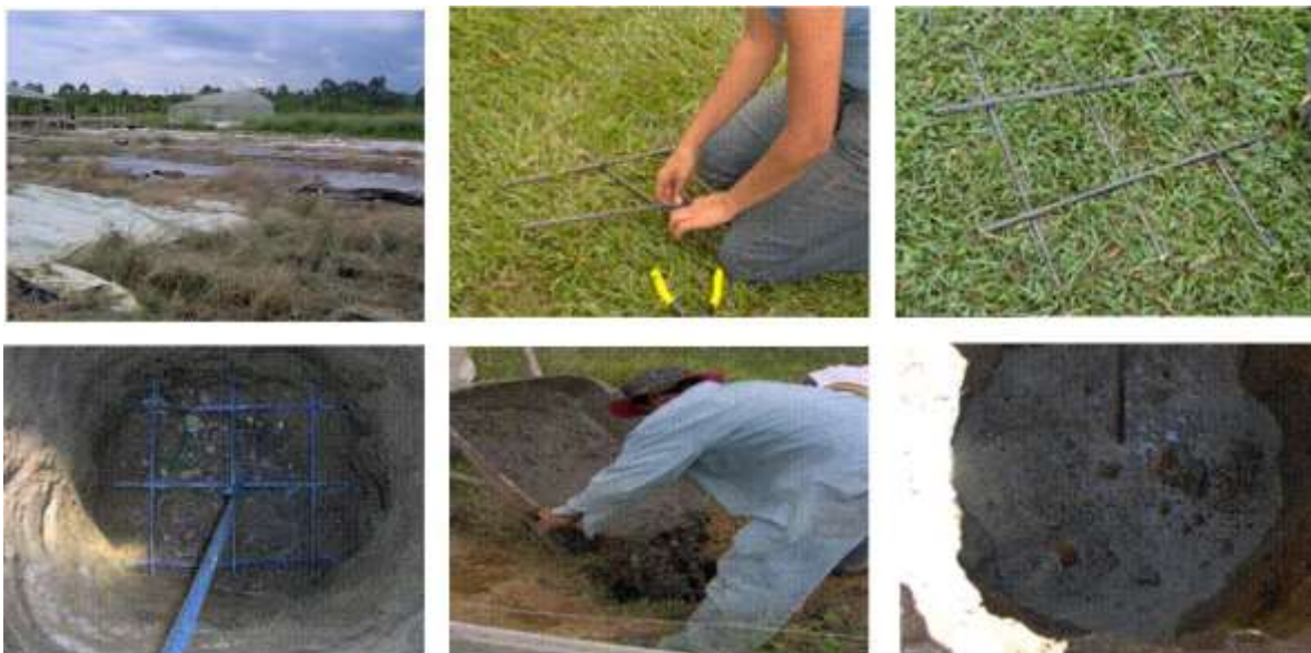
Figura 9: labores de cimentación para instalación de las columnas (Parra et al., 2020)
