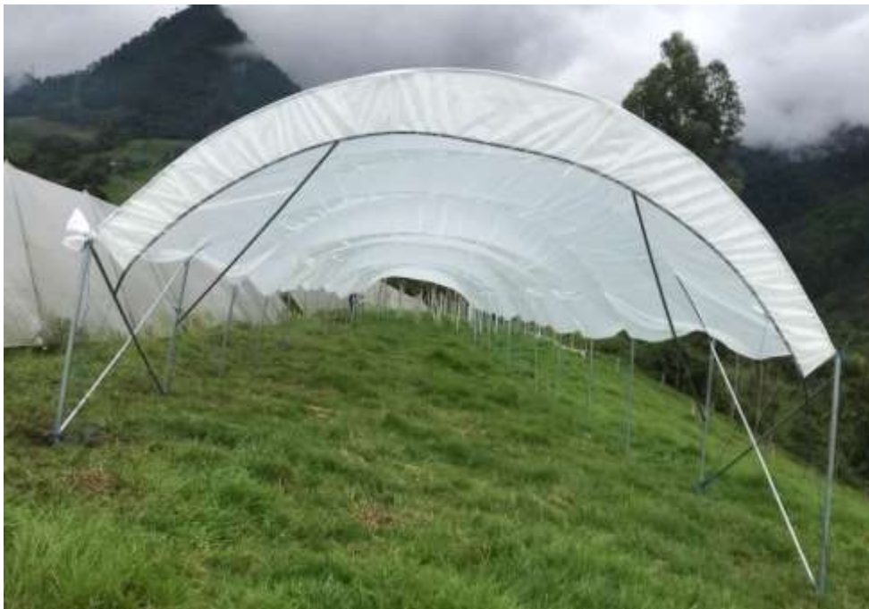
Figura 27: vista frontal del macrotúnel con los refuerzos y cruces de San Andrés. (Orozco Orjuela 2017)
