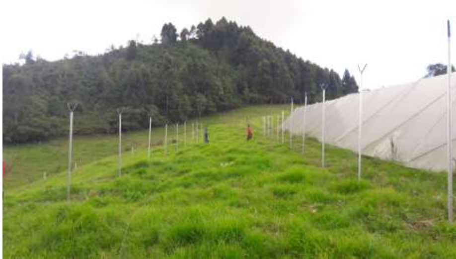
Figura 22: Postes instalados en campo. (Orozco Orjuela 2017)
