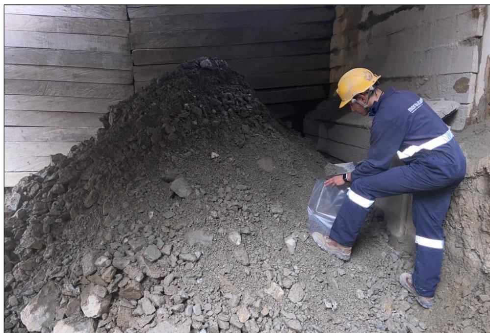
Figura 12. Toma de muestra de acopio, con la proporción correspondiente de finos y gruesos. (Fuente: autor)
