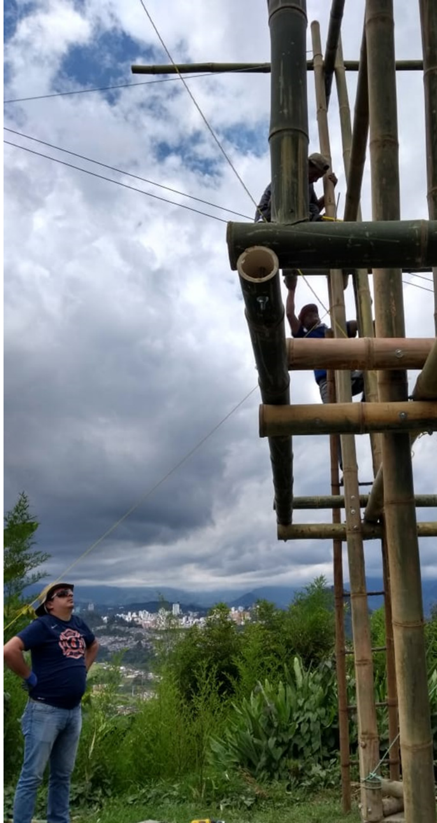
Figuras 44. Proceso de construcción de la obra. Fuente: Archivo propio.
