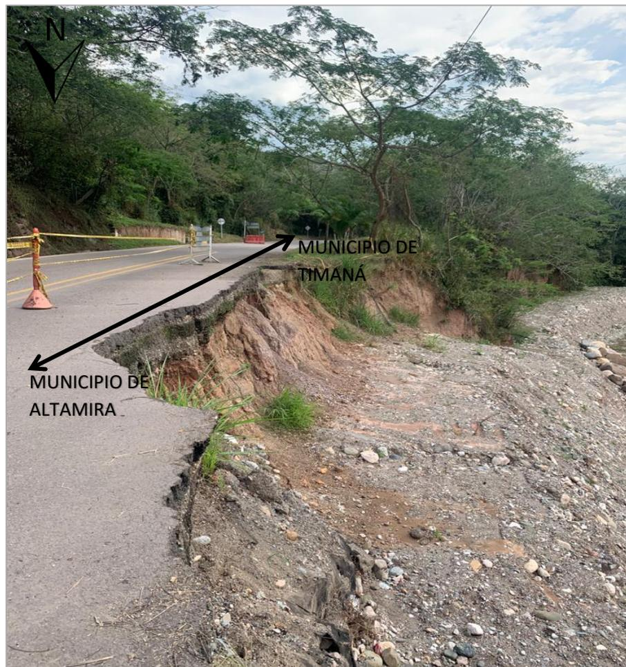
Figura 18. Evidencia de pérdida de banca producto de la socavación lateral dada por el río Timaná, en la vía que comunica el municipio de Timaná con Altamira.
