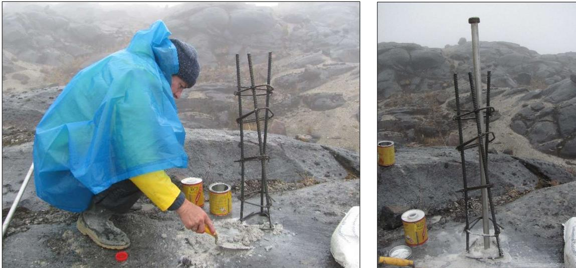
**Figura 13.** Fotografías que ilustran el cementado de la varilla de acero inoxidable y la estructura de hierro (Ordóñez, 2018).
