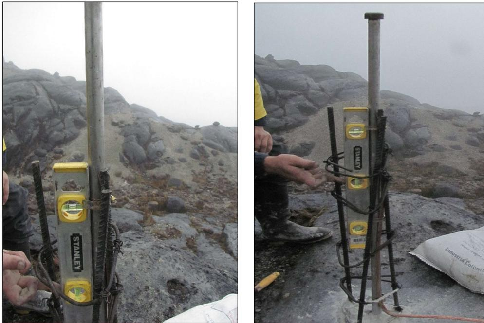
**Figura 15.** Fotografías que ilustran el proceso de nivelación de la varilla de acero inoxidable (Ordóñez, 2018).
