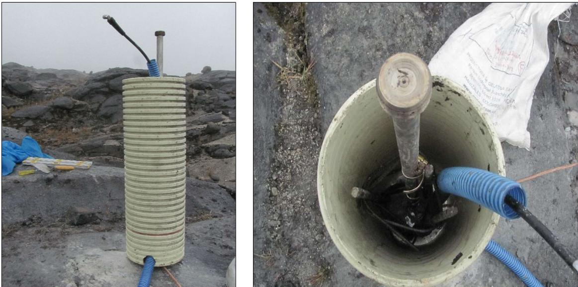
**Figura 16.** Fotografías del montaje de la formaleta PVC y de la manguera para protección del cable de conexión entre la antena GNSS y el receptor GNSS (Ordóñez, 2018).
