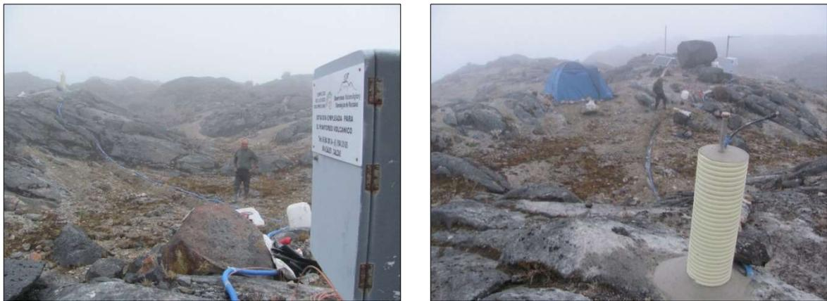
**Figura 28.** Fotografías que ilustran la conexión del cable de cobre entre la antena y el gabinete (Ordóñez, 2018).
