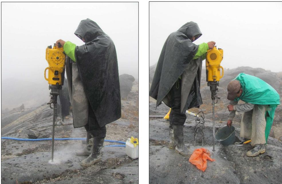
**Figura 10.** Fotografías que ilustran el proceso de perforación de la roca empleando el taladro percutor (Ordóñez, 2018).
