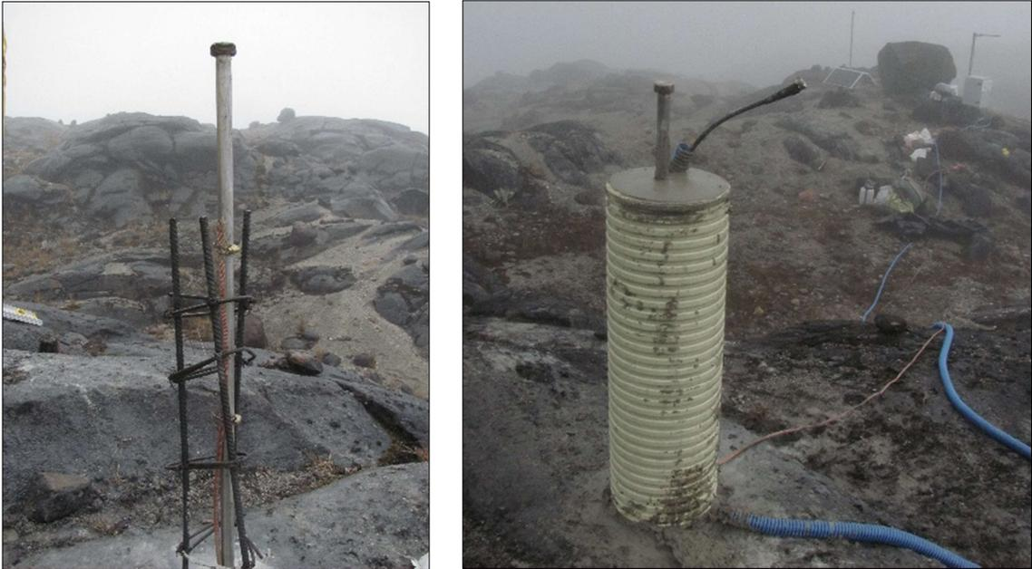
**Figura 27.** Fotografías que ilustran la conexión del cable de cobre a la varilla de acero inoxidable y la disposición del mojón de concreto (Ordóñez, 2018).
