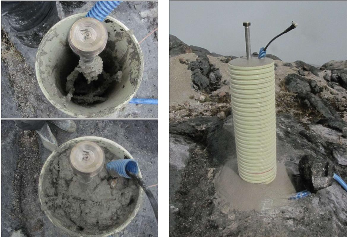
**Figura 17.** Fotografías de la fundición del mojón de concreto y la disposición final de la varilla para el acople de la antena GNSS (Ordóñez, 2018).
