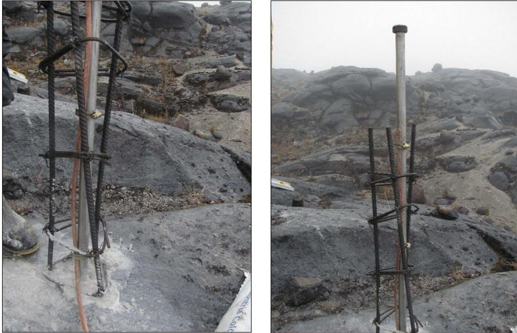
**Figura 14.** Fotografías que ilustran el proceso de acople del cable de cobre para la conexión al sistema de protección contra descargas eléctricas (Ordóñez, 2018).
