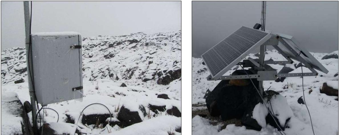
**Figura 24.** Fotografías del gabinete de protección de equipos y los paneles solares de la estación GNSS (Ordóñez, 2018).
