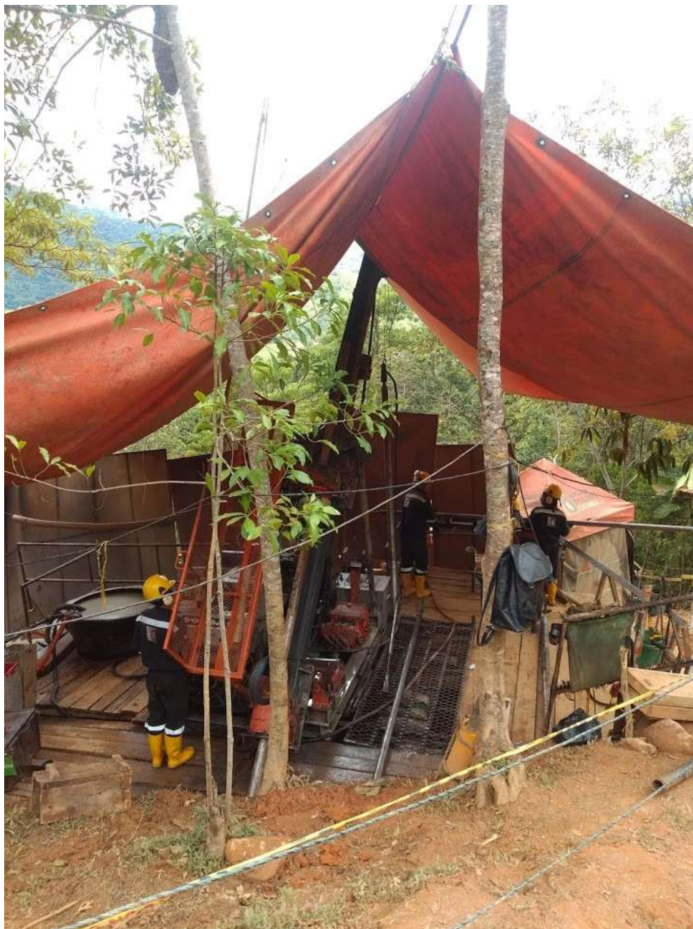
Figura 13 Plataforma de perforación diamantina. Podemos observar el montaje de la plataforma para llevar a cabo la perforación diamantina, allí se realizó una estabilización previa del terreno donde va anclada la maquina y se puede evidenciar que se garantizan los servicios y condiciones necesarias para su ejecución. Publicada con permiso de Mauricio Marín.
