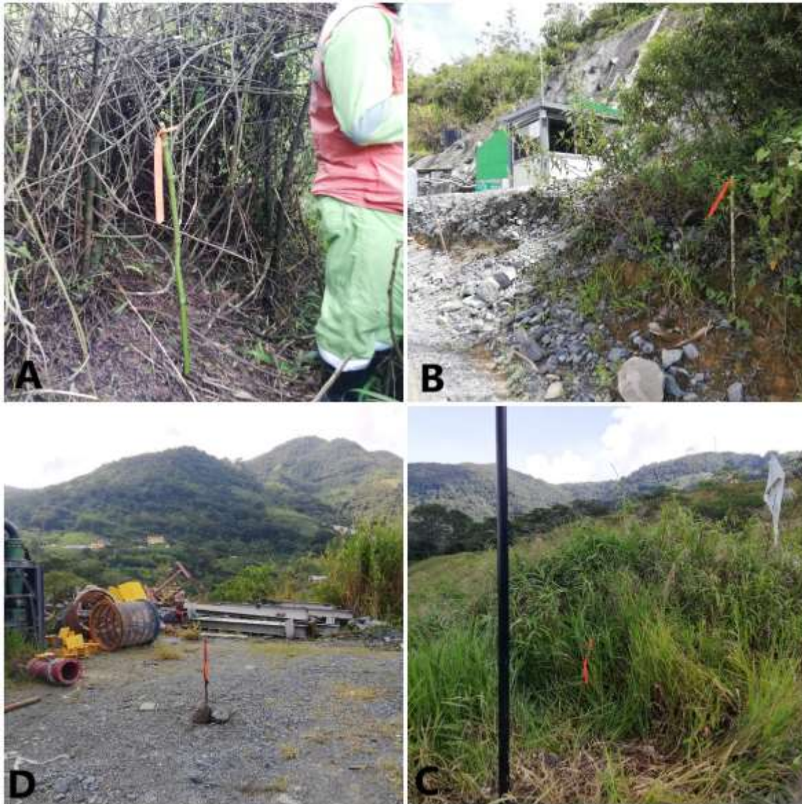
Figura 18. en las 4 imágenes se presentan los sitios o puntos de perforación debidamente rotulados con datos para su posterior ubicación y arreglo de plataformas.
