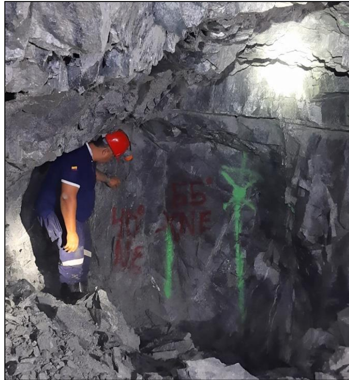
Figura 28: marcación de frentes con guía de línea de perforación.
