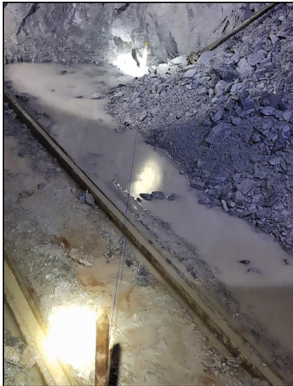
Figura 27: línea de perforación montada con estacas y fibra.
