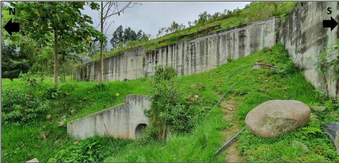
*Figura 29. Muro de contención y sistema de drenaje con una alcantarilla de 34".*
