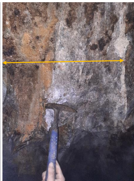
Figura 23. Típica falla, compuesta por granodiorita molida, localmente oxidada; se localiza en el Nivel Grillos Nivel #1.
