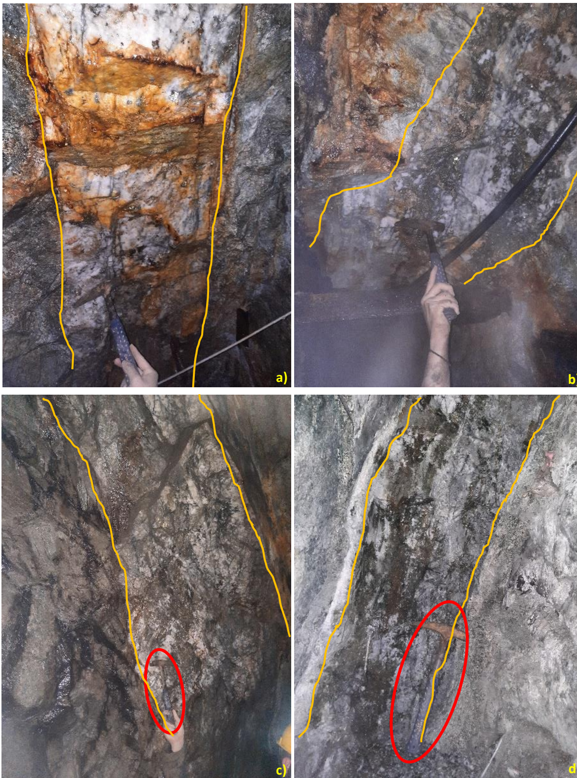
Figura 25. Fotografías representativas de la veta Grillos en el nivel #1 de E a W. a) Al inicio de la guía; veta a techo con 3% de sulfuro en cristales y bandeado, oxidación supérgena, cuarzo silicificado, buzamiento al S. b) Al intermedio de la guía; veta a techo con 15% de sulfuro masivo y en cristales, cuarzo silicificado, Buzamiento al S. c) Al final de la guía; veta en tala bordón N con 20% de sulfuro masivo y en cristales, cuarzo silicificado, buzamiento al S. d) Frente de la sobreguía 2 al W del tambor #11; veta con 15% de sulfuro masivo, cuarzo granular, se localiza en zona de falla, buzamiento local al N.
