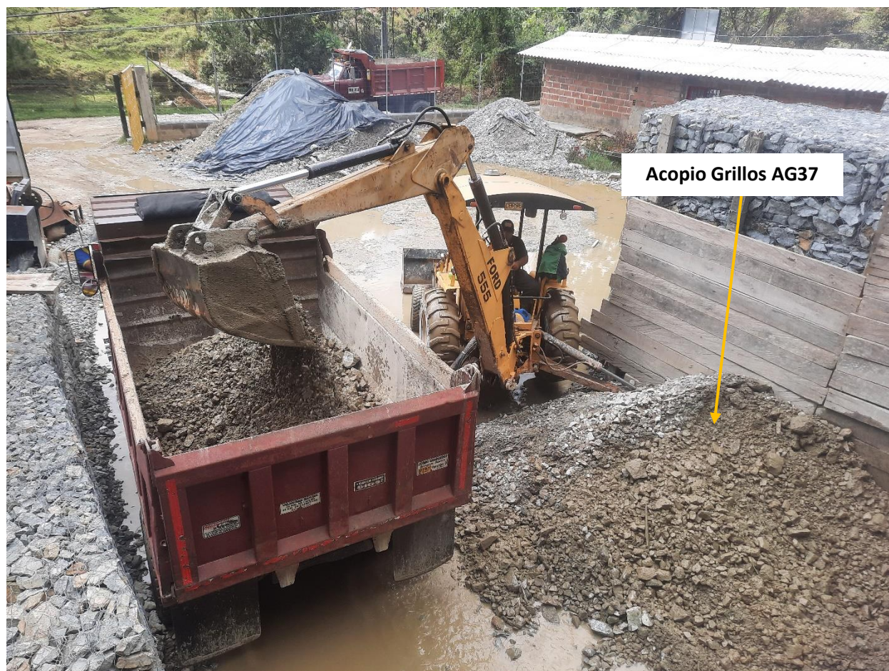
Figura 32. Volqueta siendo cargada con material del Acopio Grillos con destino a Antioquia Gold.
