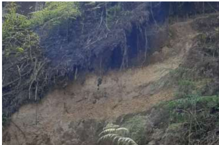
Figura 48. Formación superficial encontrada en SCB-10. Corresponde nuevamente a depósitos de caída piroclástica de alto espesor. Entre SCB-9 y SCB-10 está la superficie de contacto entre los depósitos de caída piroclástica y la Formación Casabianca.
