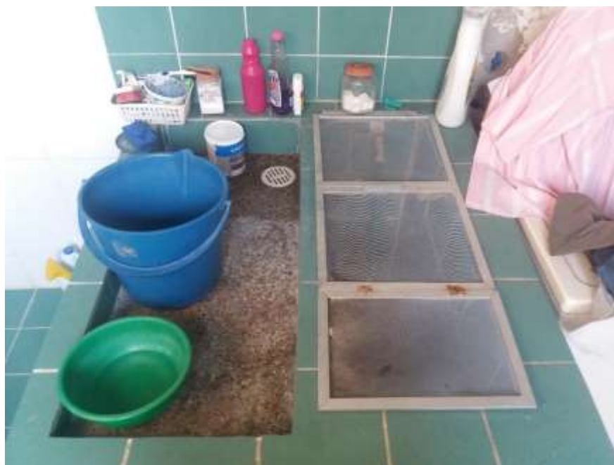
Figura 2. Tapa enmallada y plegable otorgada por la Fundación Santa Fe de Bogotá en una casa del barrio Kennedy.
