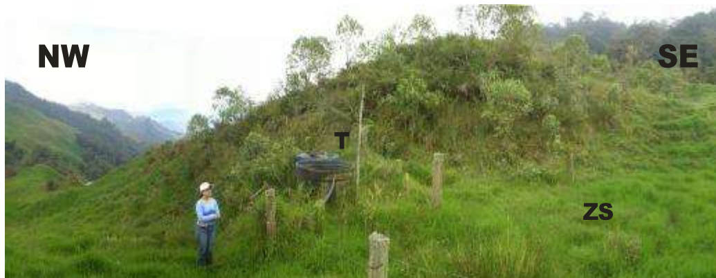
Figura 25. Tanques de abastecimiento ubicados cerca de la corona (T) y zona de saturación por el escape de esta agua (ZS)
