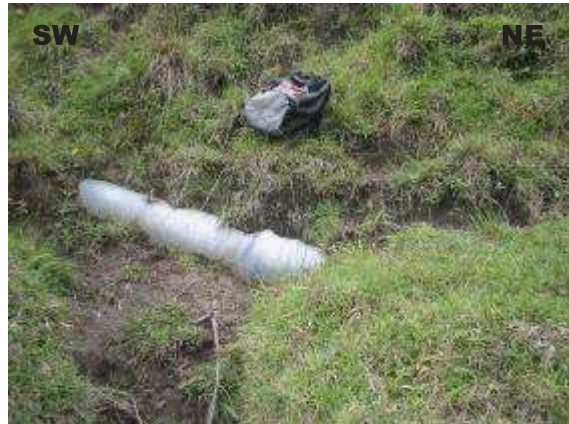
Figura 21. Tubería expuesta por problemas de erosión en surco y terraceo.
