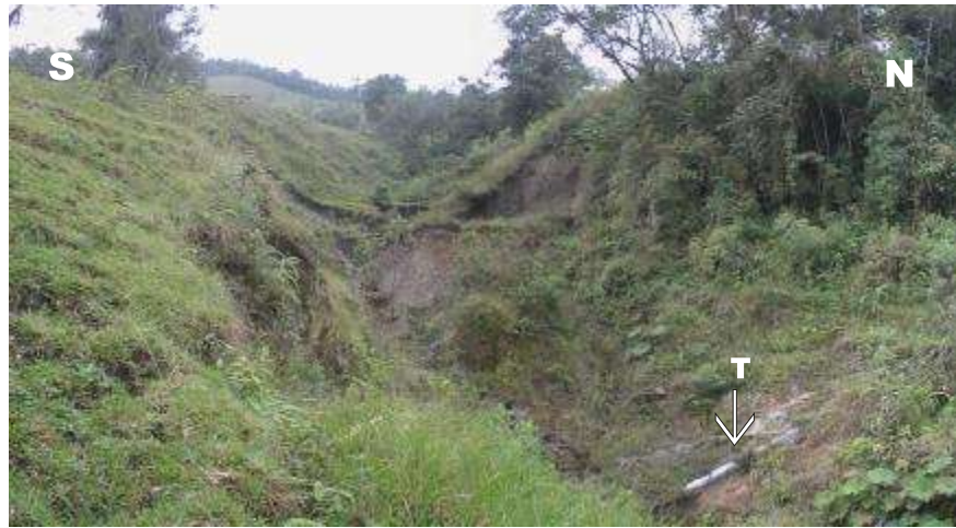
Figura 9. Cárcava ubicada en predios de la hacienda de los Blandon, se observa en la parte baja como afecta la tubería de aducción (T)
