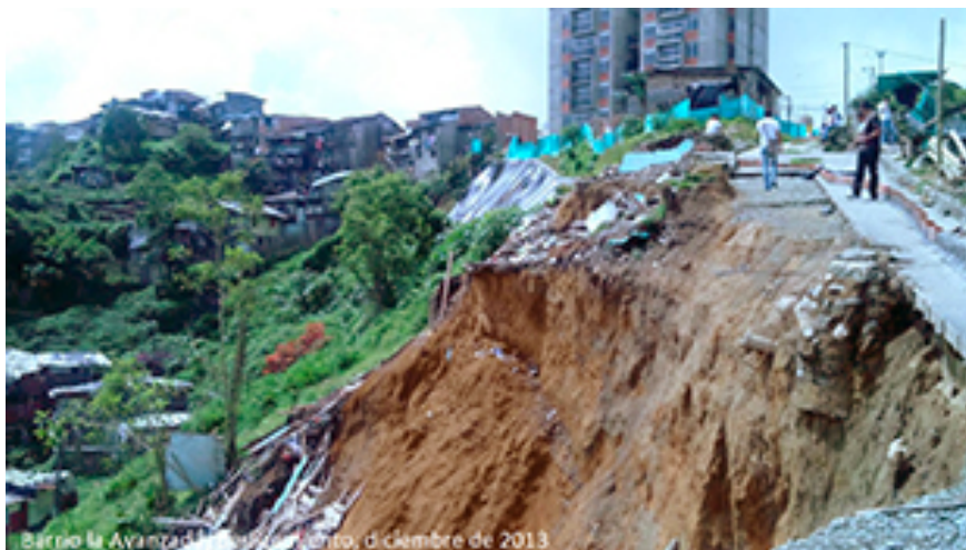
Figura 97. Derrumbe por lluvias en 2013
