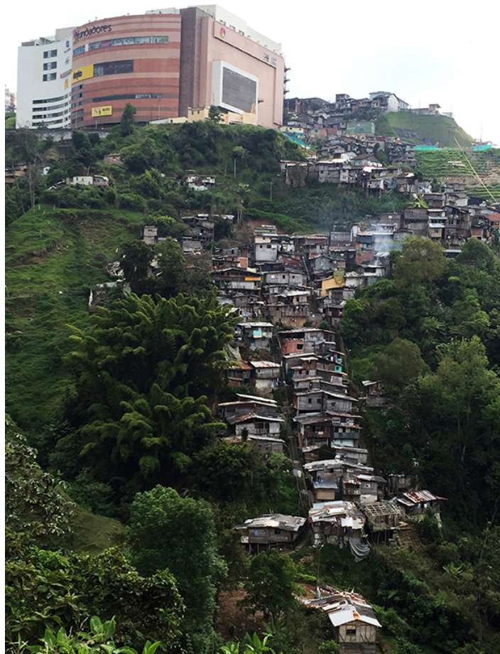
Figura 52. Fotografía del Centro Comercial Fundadores, y San José, barrio Sierra Morena. Se observa parte de zona alta y baja.
