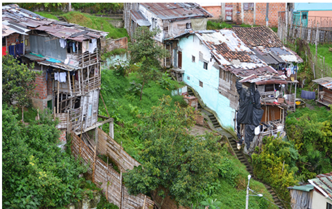
Figura 74. Viviendas en bahareque y madera ubicadas en ladera
