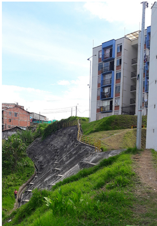
Figura 99. Muro de contención
