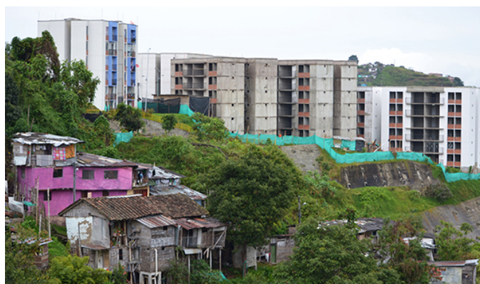
Figura 98. Edificios para reubicación de personas en La Avanzada
