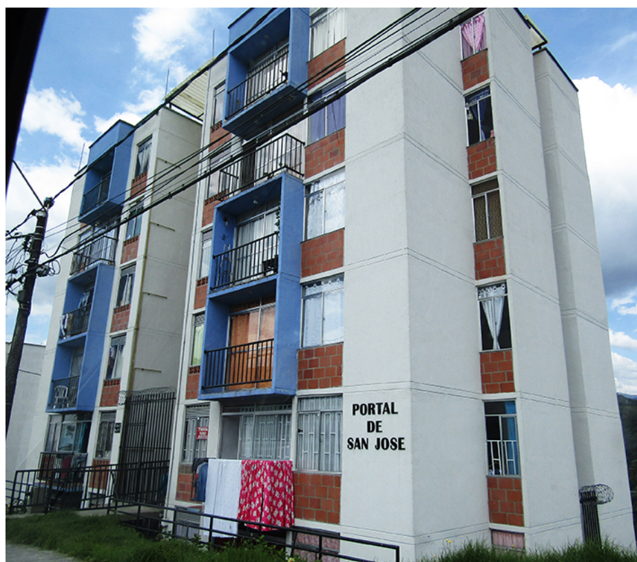
Figura 101. Primer edificio entregado en el macroproyecto
