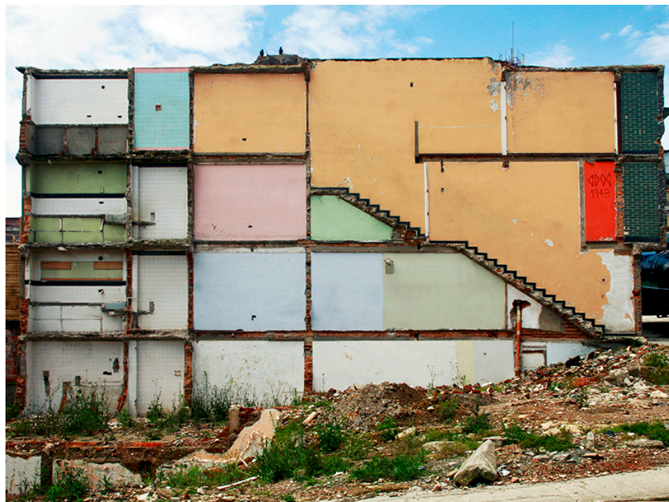
Figura 75. Restos de viviendas en material ubicadas en la parte media
