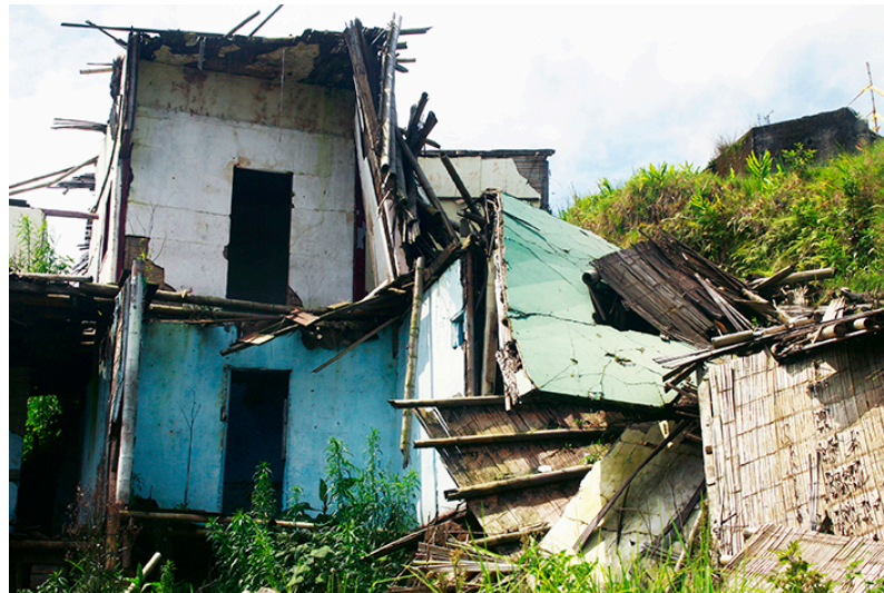
Figura 88. Restos de las demoliciones
