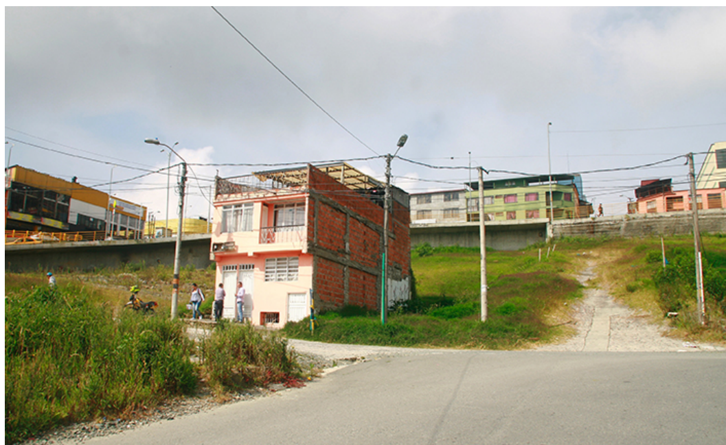
Figura 93. Casa de José Eduardo Rentería en proceso de expropiación, barrio Delicias
